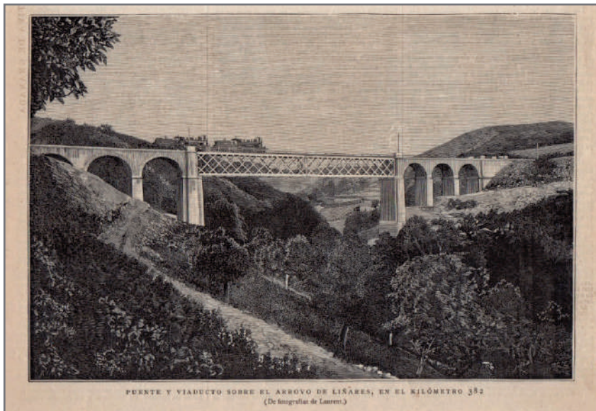
VIADUCTO DE LIÑARES. Sobre el río Liñares entre Bóveda y Oural. Seis arcadas de piedra con tramo central de hierro de 60 metro de longitud. "La Ilustración Española y Americana". 8 de septiembre de 1883
