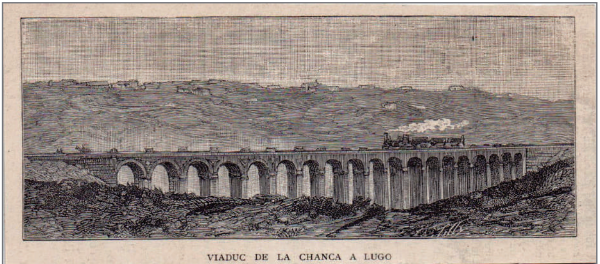
VIADUCTO DE LA CHANCA sobre el río Rato. 298 m. de longitud y 29 m. de alto en el punto máximo.
